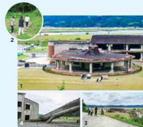
1 裏山から見える校舎 2 実際に学校の裏山に登ってみました（中々急な坂道です） 3 裏山から見える景色 4 校舎と体育館を繋いでいた渡り廊下
